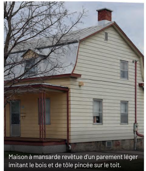
Maison à mansarde revêtue d'un parement léger imitant le bois et de tôle pincée sur le toit.
