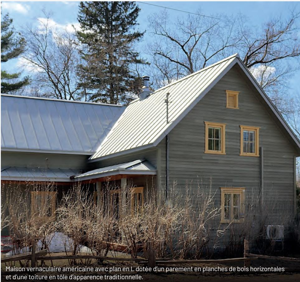
Maison vernaculaire américaine avec plan en L dotée d'un parement en planches de bois horizontales et d'une toiture en tôle d'apparence traditionnelle.
