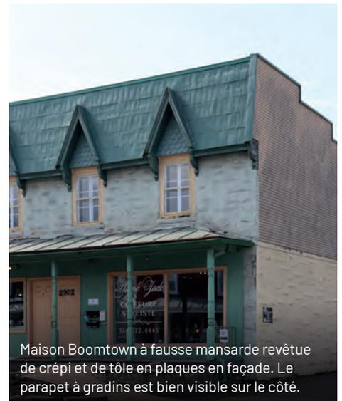
Maison Boomtown à fausse mansarde revêtue de crépi et de tôle en plaques en façade. Le parapet à gradins est bien visible sur le côté.
