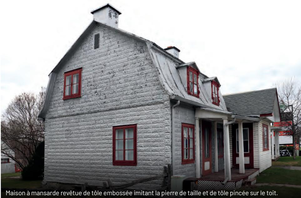
Maison à mansarde revêtue de tôle embossée imitant la pierre de taille et de tôle pincée sur le toit.
