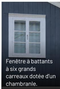
Fenêtre à battants à six grands carreaux dotée d'un chambranle.
