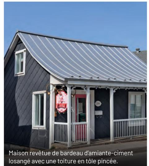
Maison revêtue de bardeau d'amiante-ciment losangé avec une toiture en tôle pincée.
